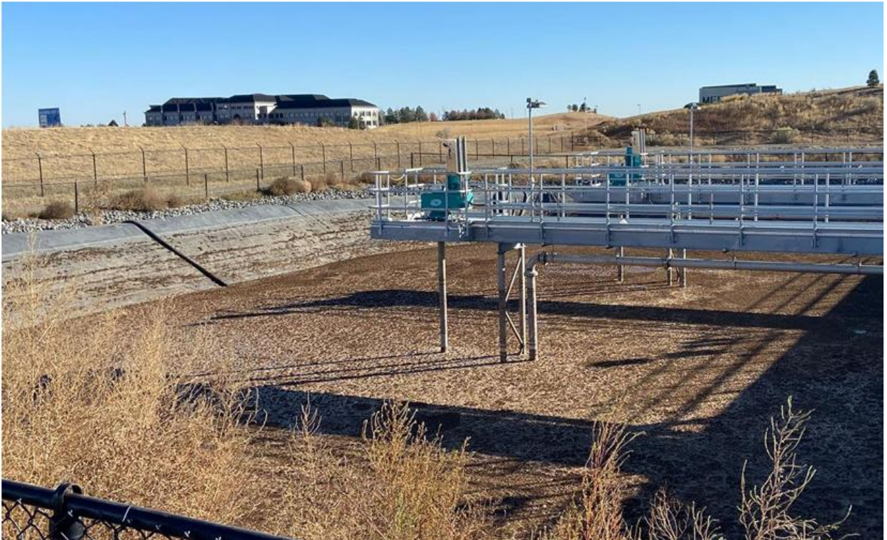
Figura 5: impianto di depurazione di Meridian, Colorado
