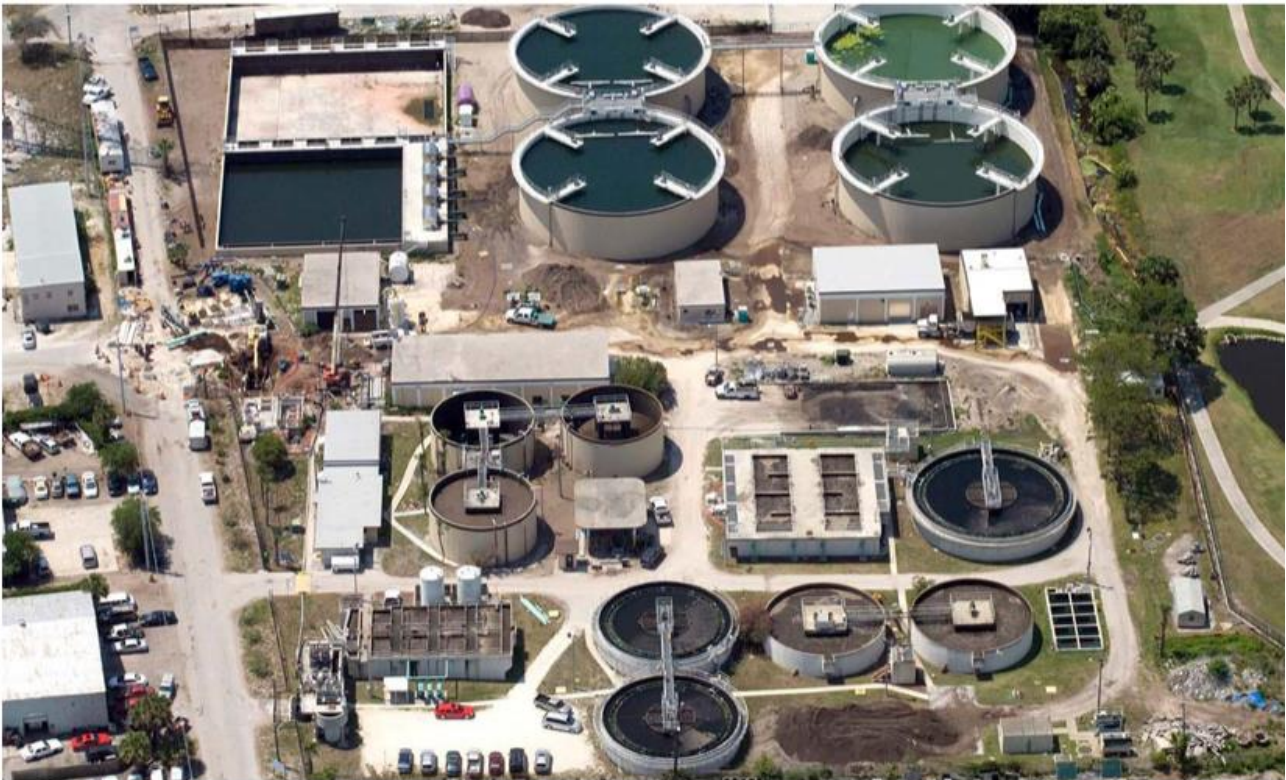
Figura 4: impianto di depurazione di Jacksonville, Florida
